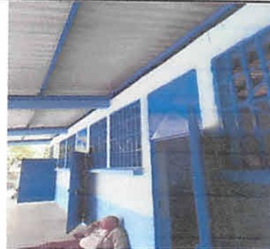
Foto 4: cambio de cocina de madera por cambio de cocina de block con costaneras de metal y lamina troquelada 26"
