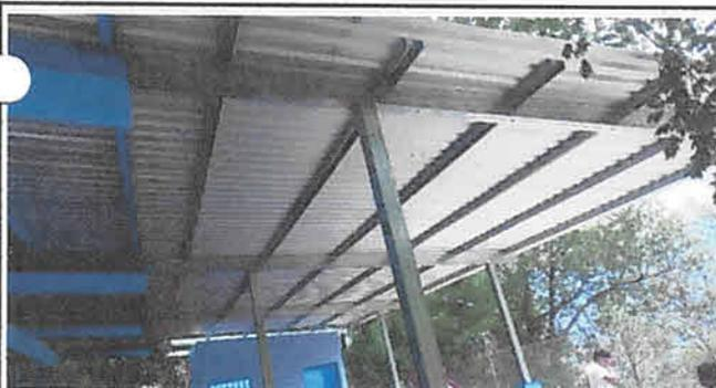
Foto 5: cambio de cocina de madera por cocina de block con costaneras de metal y lamina troquelada 26"
