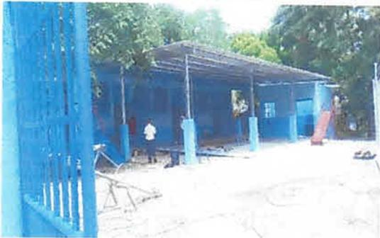
Foto 3: Cambio de cerco de maya con madera, por cerco de maya con tubo galvanizado y cambio de cocina de madera por cocina de block
