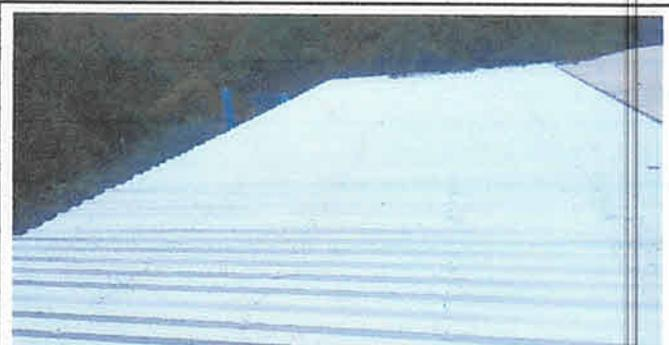
Foto 6: Cambio de cocina de madera por cocina de block con costaneras de metal y lamina troquelada 26"
